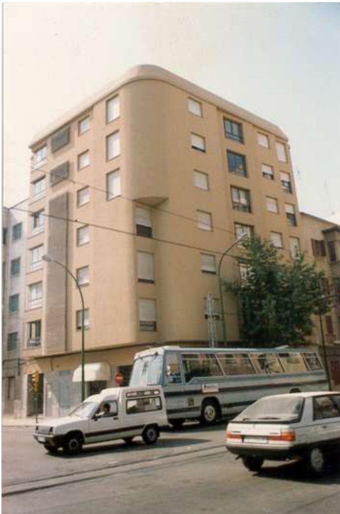
Ilustración 4 - Fotografía de fachada.
