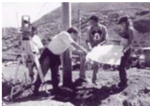
Proceso de ejecución material de los trabajos urbanos (COFOPRI).
