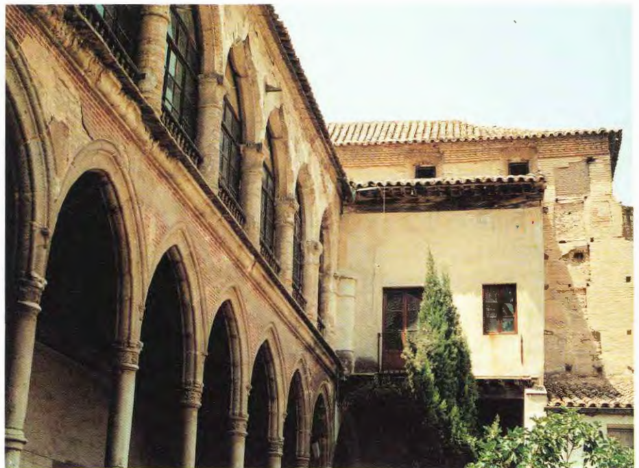
Inmueble que forma parte del Monasterio de Santo Domingo. Restaurado por la C.G.C.C.T. para su rehabilitación e instalación de la Gerencia Regional de Castilla-La Mancha y la Gerencia Territorial de Toledo.
